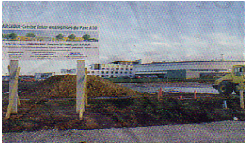
Les engins de terrassement ont tout juste commencé à préparer le terrain sur lequel s'élèvera le bâtiment.
